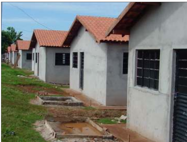
Construção de casas será a primeira etapa de execução do projeto
