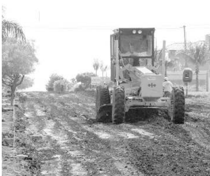
Máquinas já operam na rua Hayel Bon Faker, preparando ruas para a implantação do asfalto comunitário no Jardim Europa
