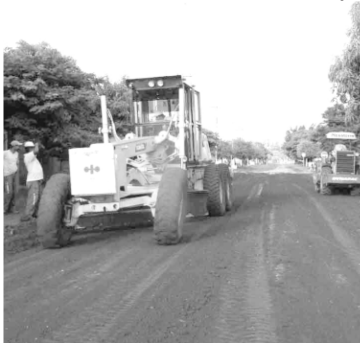
Diversos bairros da cidade serão beneficiados com as obras de asfalto
