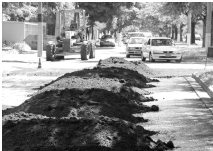
Reperfilamento da Avenida Hayel Bon Faker, um dos serviços realizados com apoio do Estado que cebeu a emulsão asfáltica
