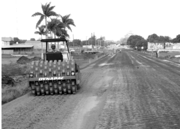
Recuperação da avenida Guaicurus
