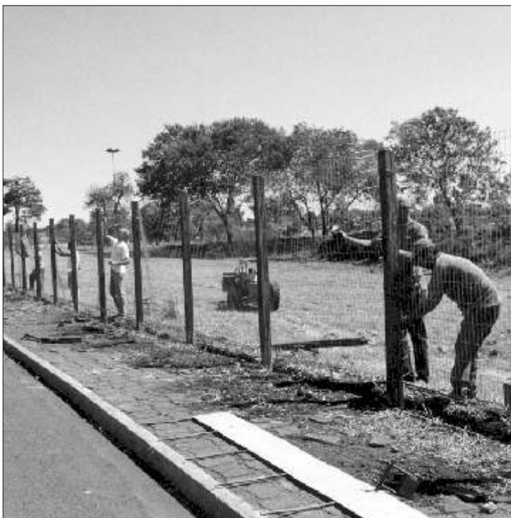
O cercamento além de proteger uma grande área verde evita afogamentos
