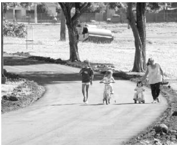
A obra da pista ainda não acabou, mas já tem pessoas aproveitando para brincar com a criança
