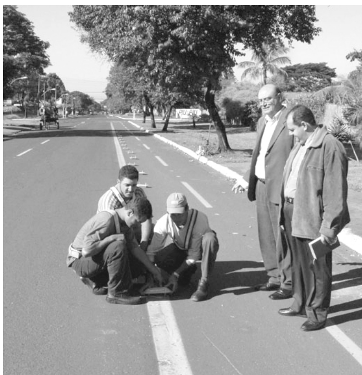
Prefeito Tetila e vereador José Silvestre vistoriam serviços de colocação de taxões nas ciclofaixas
