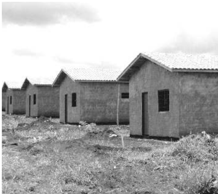
O conjunto habitacional Estrela Moroti tem 28 residências
