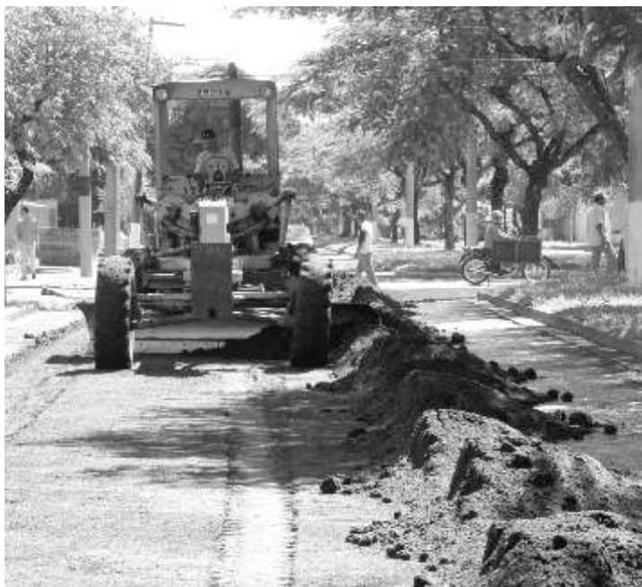
Meta é fazer 100 mil metros quadrados de reperfilamento nas ruas da cidade
